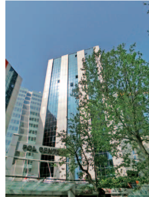
イスタンブール駐在員事務所が入居するビル
