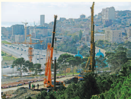
西アジアにおける地滑り対策工事
